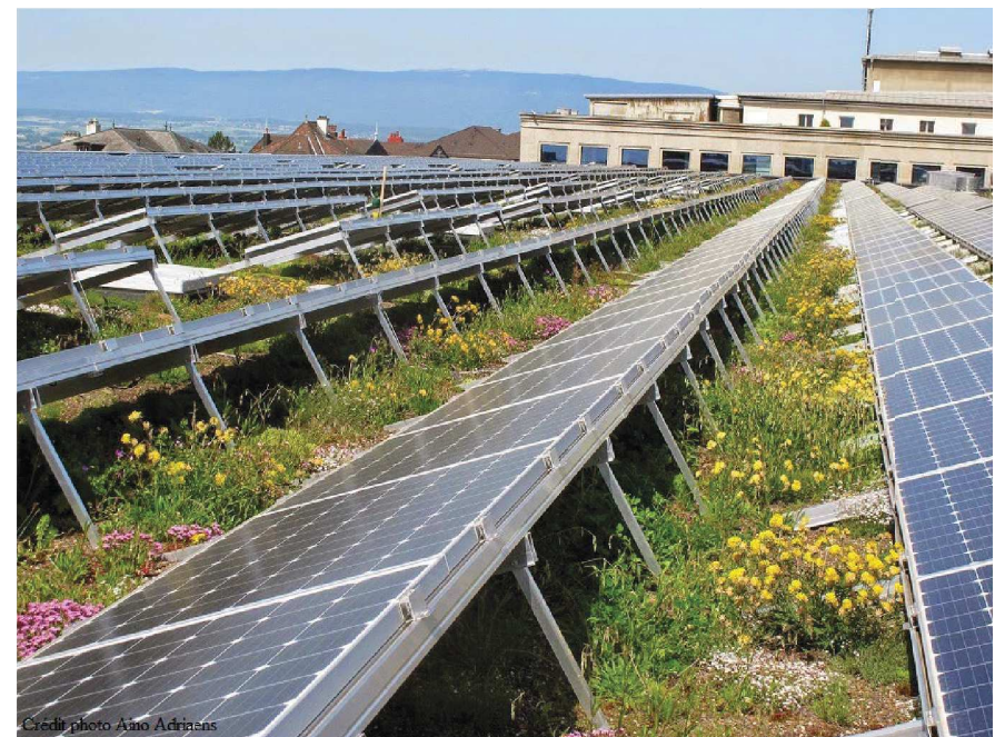
Lausanne – Utilisation de substrat inspiré des écosystèmes naturels
