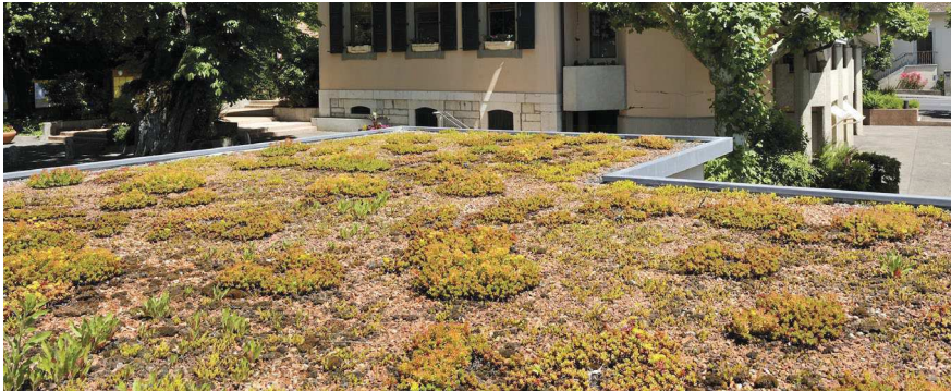
Plantation de toiture en Sedum – Pas de biodiversité
