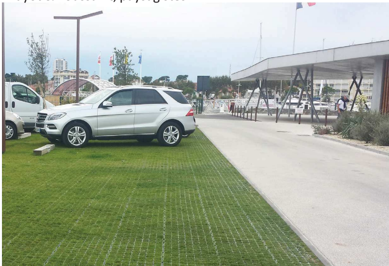
Parking perméables en zone commerciale
